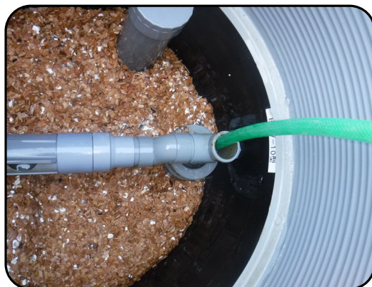
水道水による清掃状況
