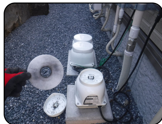
ブロア点検 エアフィルター清掃状況
