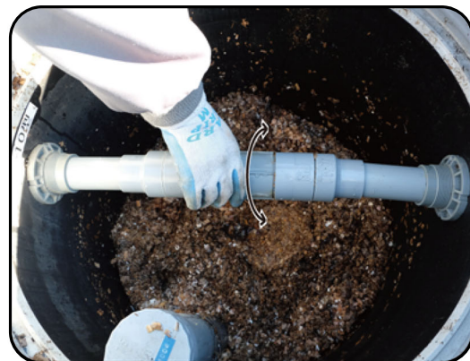
回転ゲート調整 全開状態
