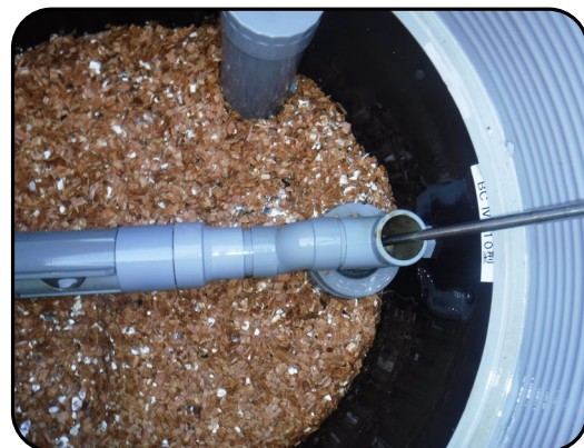
エアー攪拌状況
