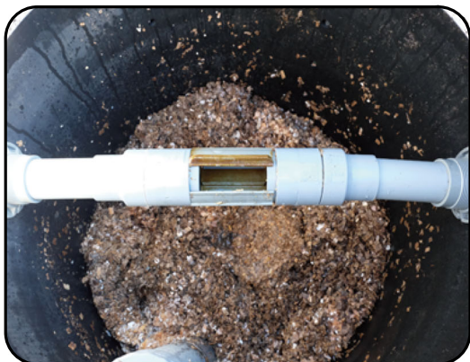
回転ゲート調整 全閉状態
