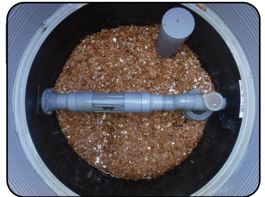
嵩上げ状況確認
