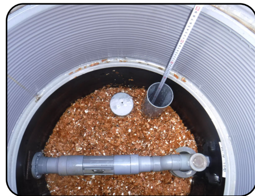
検水管内水位確認状況
